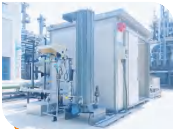
大埔煤氣廠設置供氫設施
